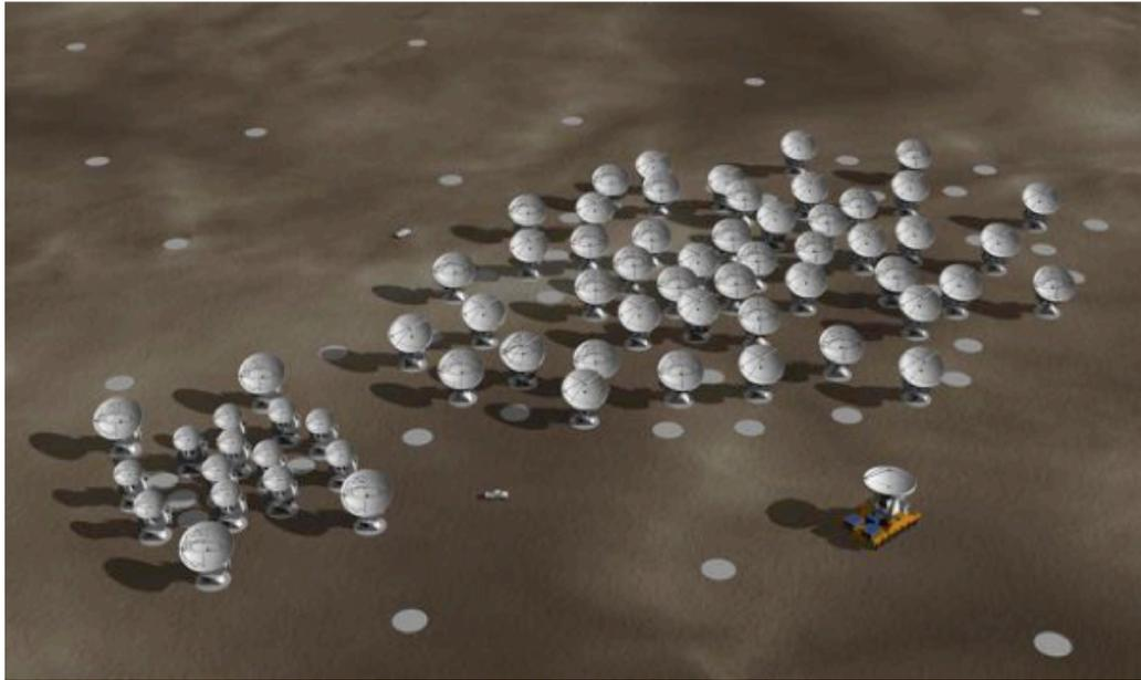
**interféromètre : 66 antennes (12m + 7m) et 2145 lignes de bases (<16 km)**
